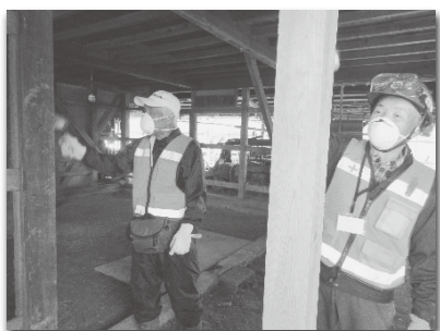
柱についた泥落とし作業
